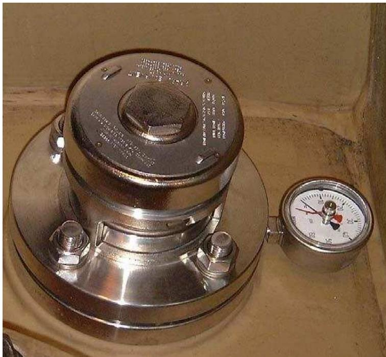
Рис. 8.1 Типичный предохранительный клапан с манометром
